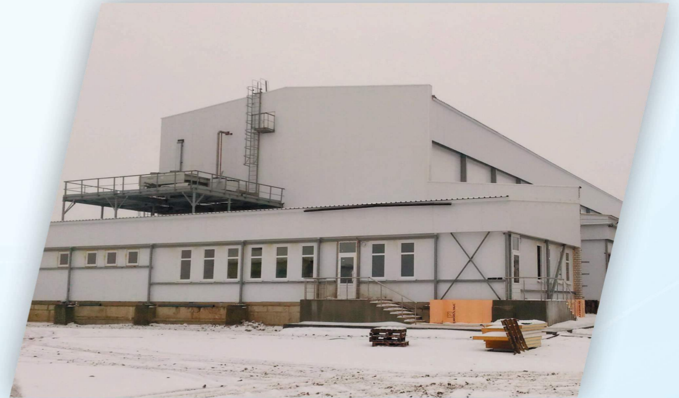
Склад-холодильник на 2000 тонн мяса птицы ОАО «Агрокомбинат Дзержинский»
