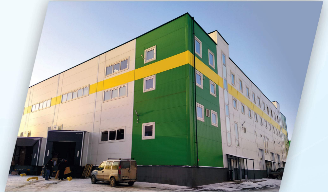
Производственное здание со встроенным АБК
