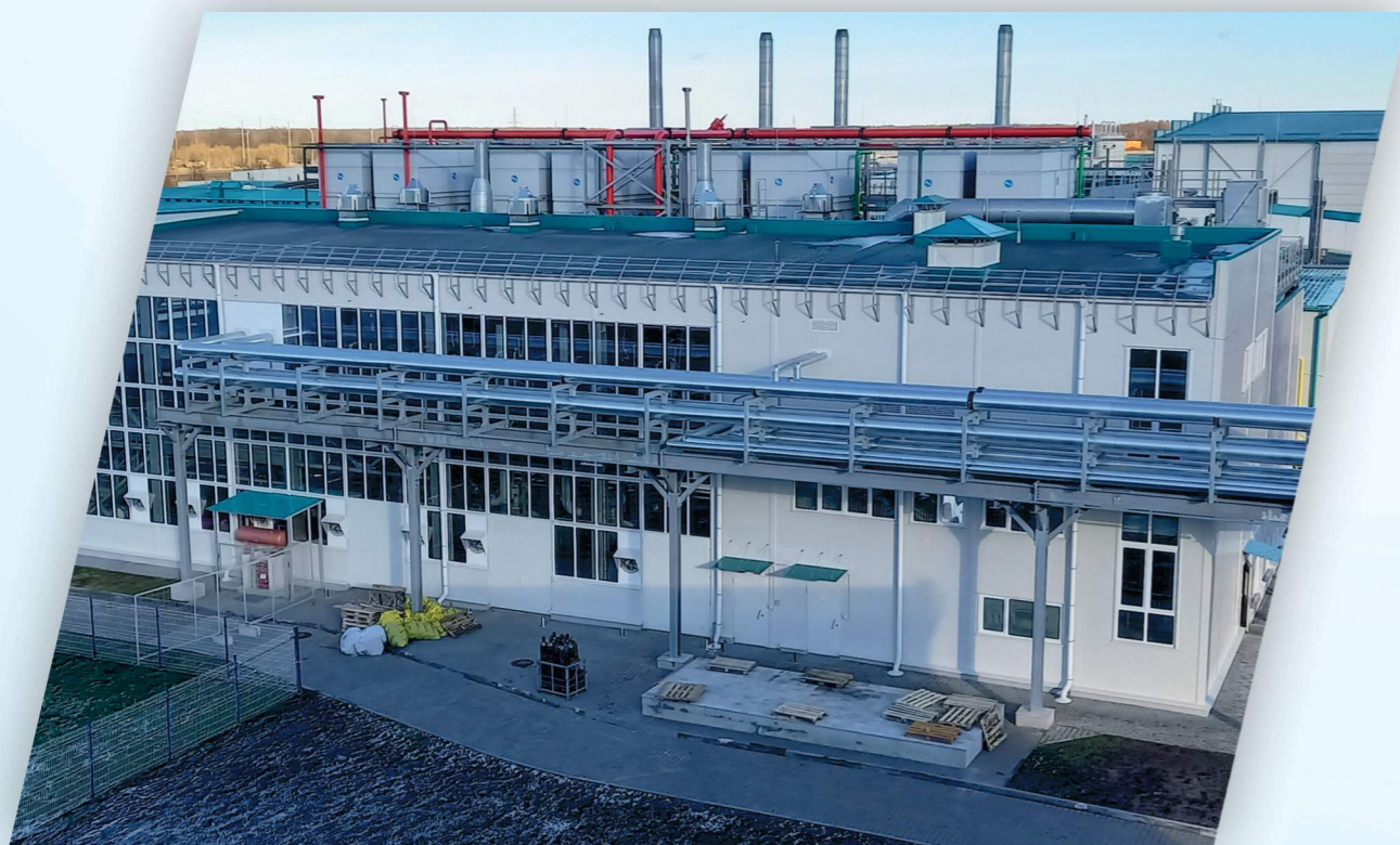
Каскадный холодильный комплекс «Санта Бремор»
