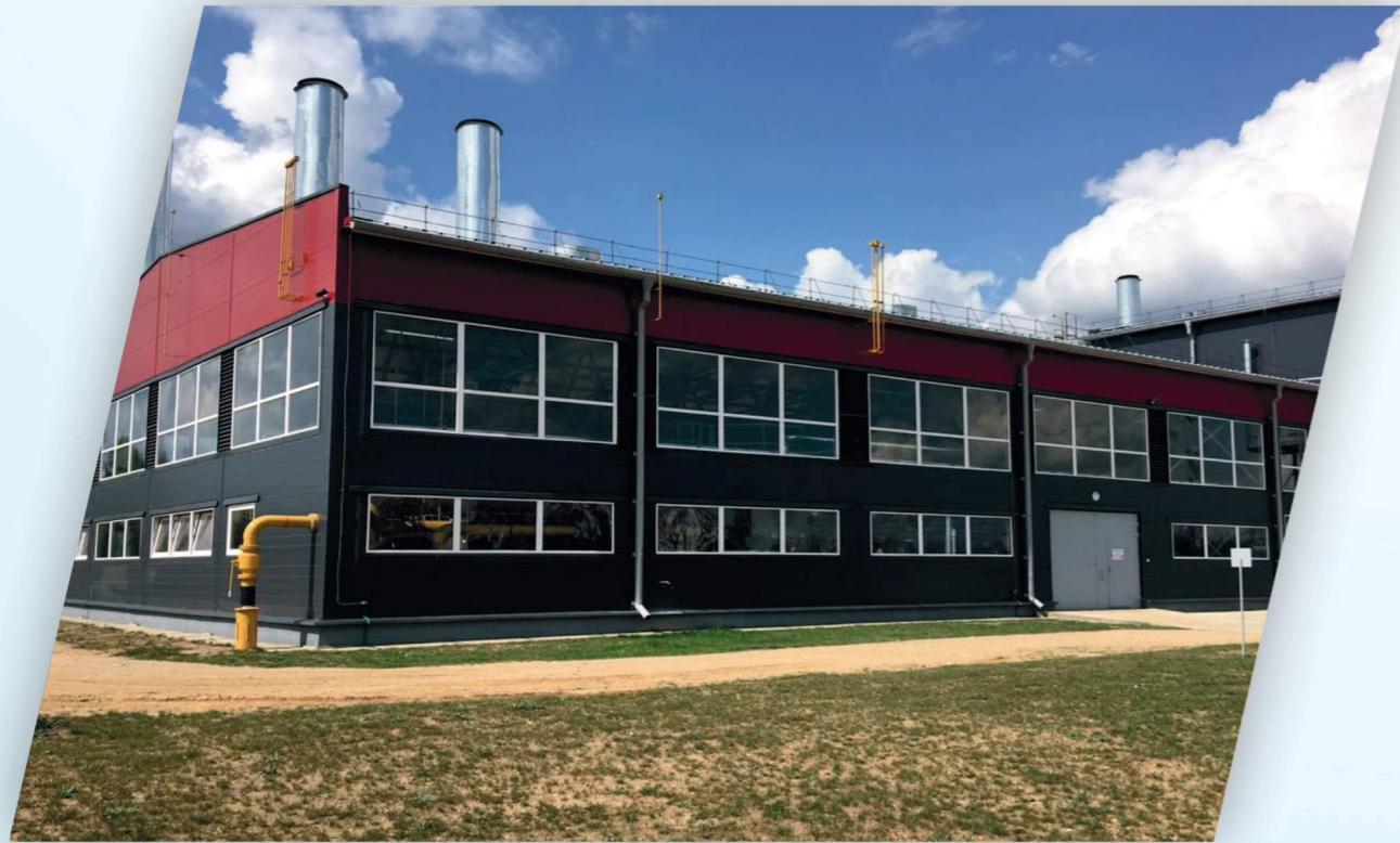
Котельная с мини-ТЭЦ на МВТ
